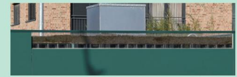
Nahaufnahme der Substratstruktur des Rückhalte-Gründachs © J. Böthling /HAMBURG WASSER
