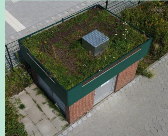
Smartes Retentionsgründach mit gesteuerter Drossel © J. Tiedemann (HAMBURG WASSER)
